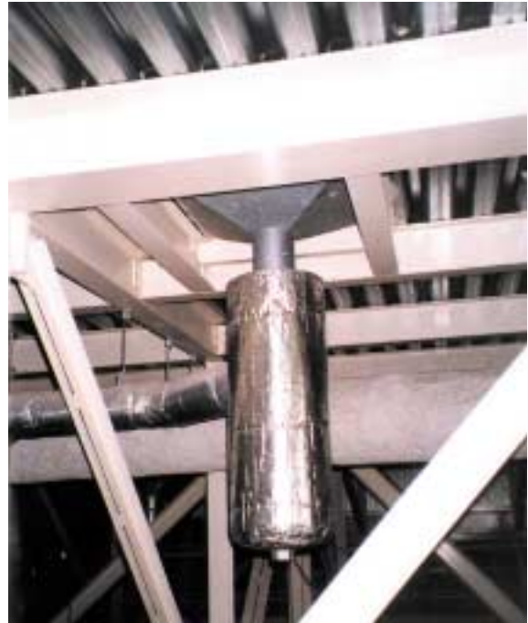
Hélistation en terrasse de l'hôpital de Nancy : décanteur-séparateur
