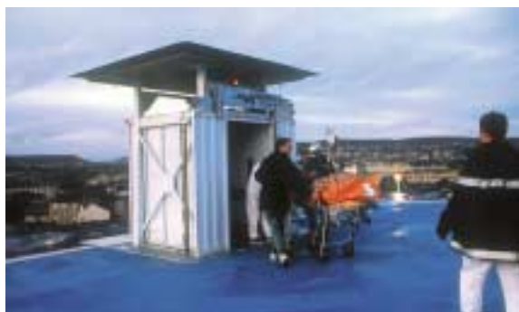
Ascenseur desservant l'hélistation en terrasse de l'hôpital de Nancy
