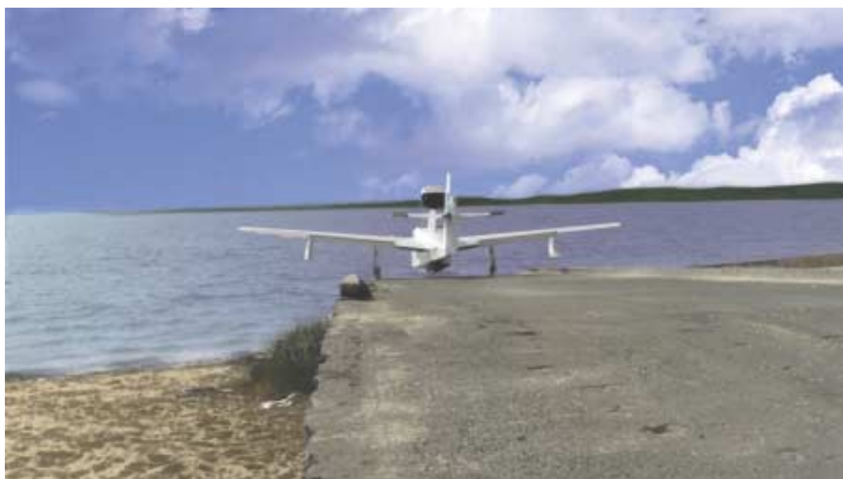
Rampe de mise à l'eau pour hydravion sur l'hydrobase de Biscarosse
