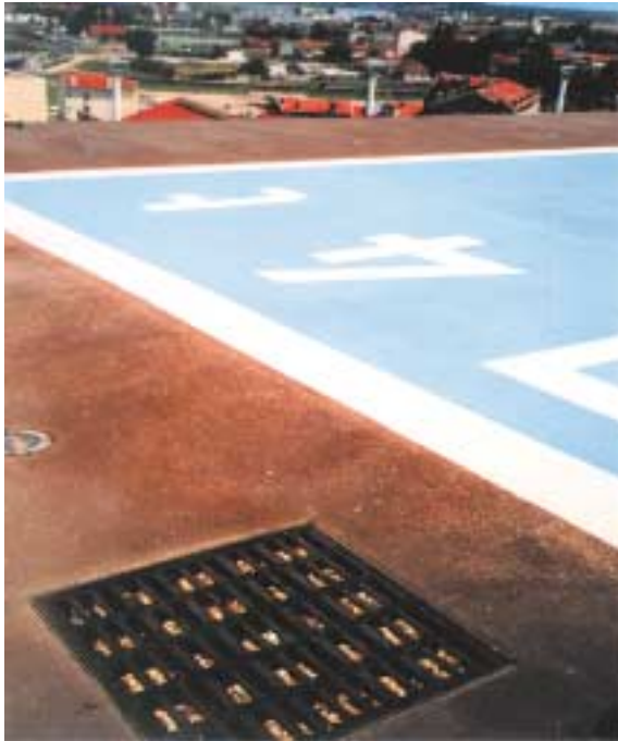
Hélistation en terrasse de l'hôpital de Nancy : avaloir destiné aux eaux de ruissellement
