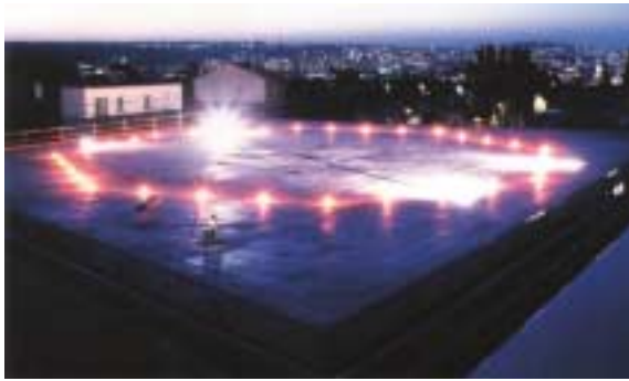
Balisage lumineux de l'hélistation de l'hôpital de Percy
