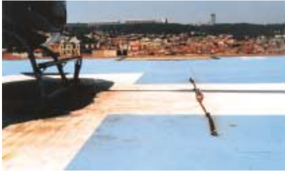
Implantation de point d'ancrage sur une hélisation
