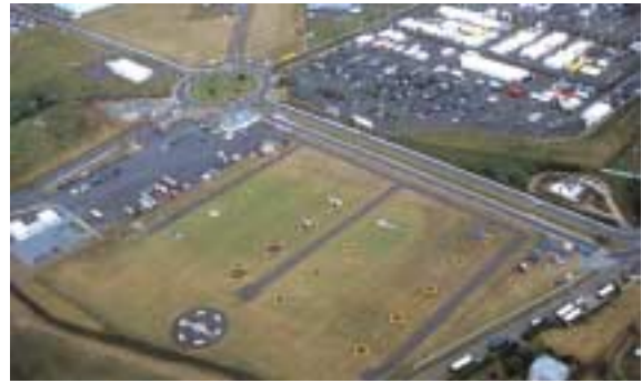
Aires de stationnement de l'hélistation de Nevers-Magny-Cours
