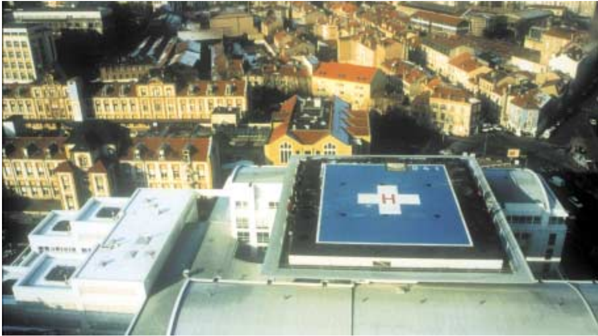
Hélistation en terrasse de l'hôpital de Nancy
