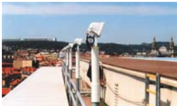
Barrières de sécurité et galerie périphérique entourant l'hélisation en terrasse de l'hôpital de Nancy
