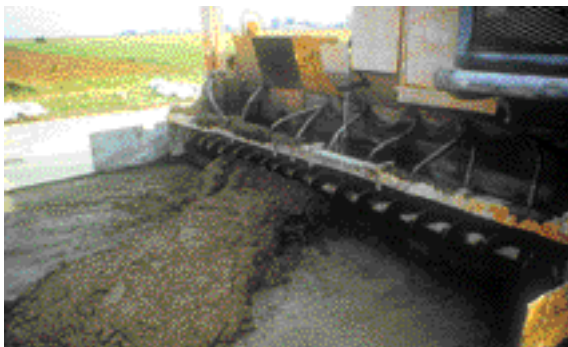
Mise en œuvre d'une surépaisseur en béton
