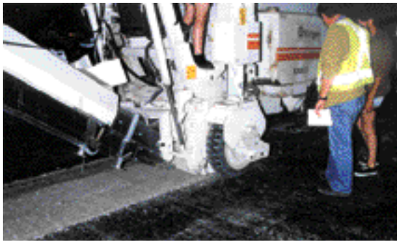
Rabotage d'une chaussée souple
