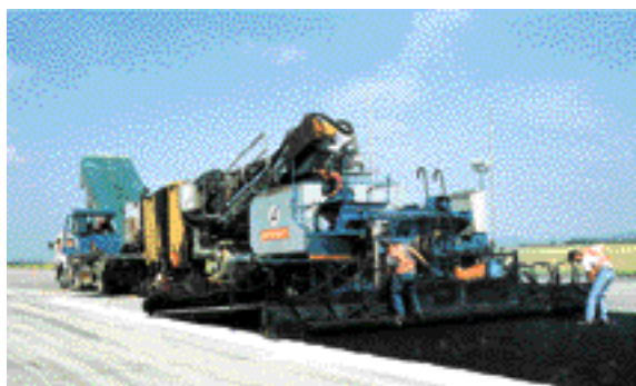
Renforcement en enrobés d'une piste en béton
