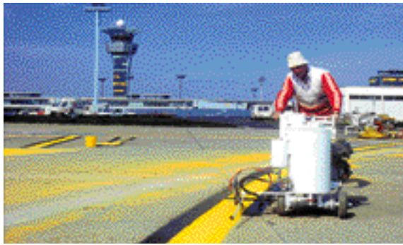
Aéroport de Paris-Orly. Remise en peinture des marques
