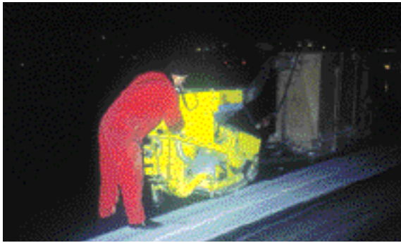
Aéroport de Marseille-Provence. Grenailage ou sablage
