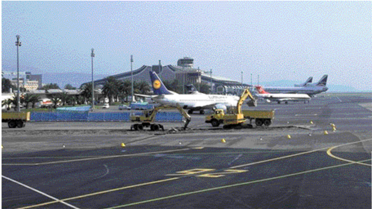
Aéroport de Nice-Côte d'Azur. Travaux d'entretien de l'aire de stationnement
