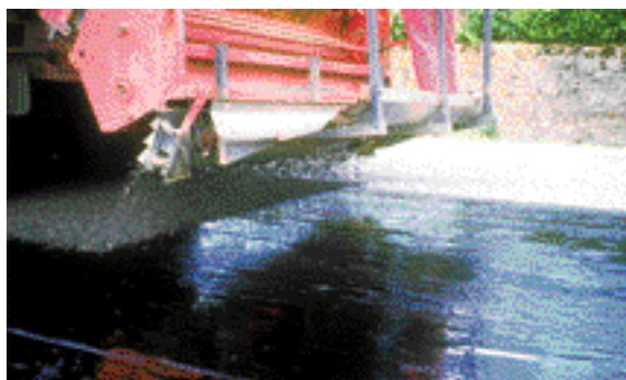
Émulsion avant gravillonnage. Mise en œuvre d'enduit superficiels
