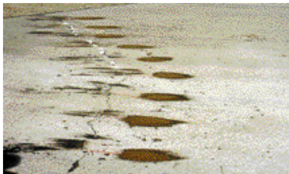
Couture d'une fissure par goujonnage
