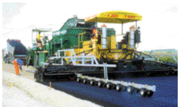
Mise en œuvre et réglage en nivellement
