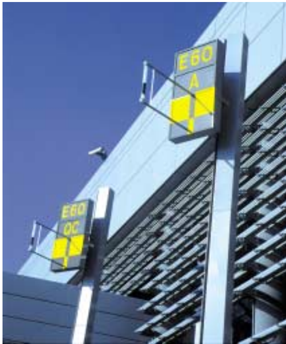
Mires de guidage apposées sur la façade d'une aéro-gare
