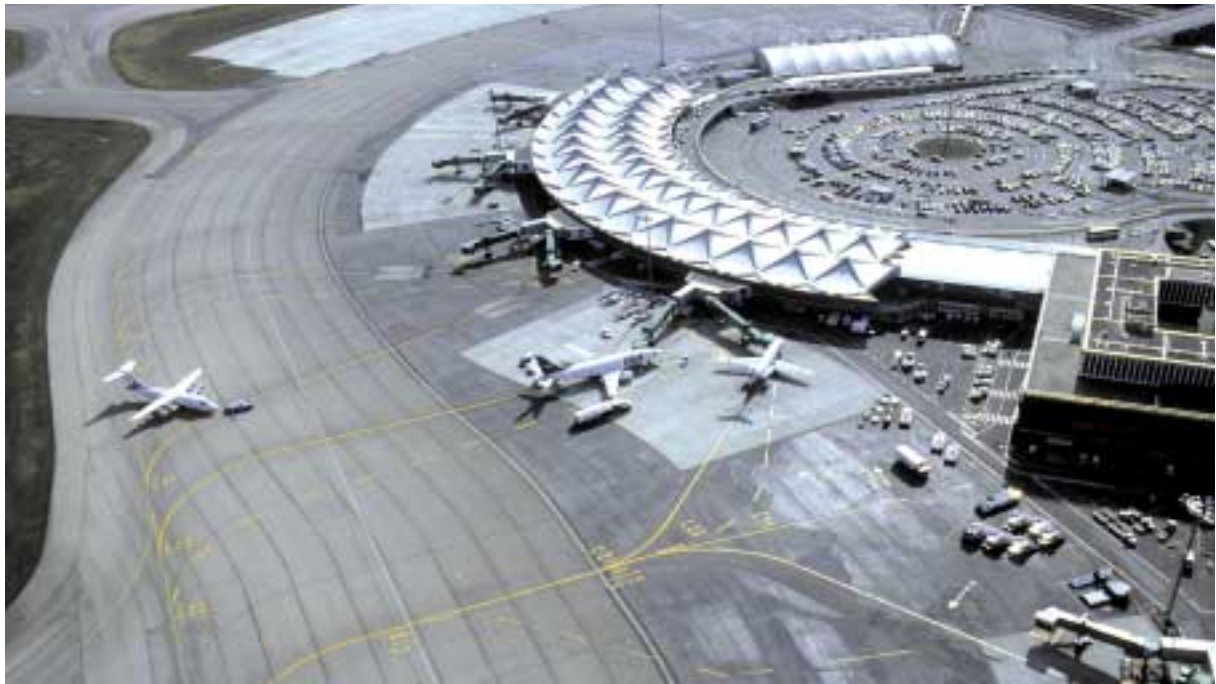
Aire de trafic de l'Aéroport de Lyon-Satolas
