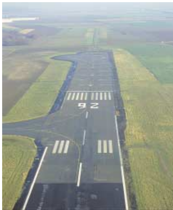
Aéroport de Lille - Lesquin. Marques au seuil 26
