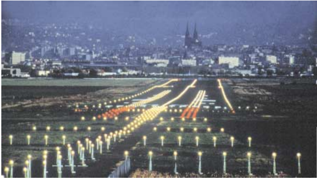
Aéroport de Clermont-Ferrand - Aulnat. Ligne d'approche et balisage de piste
