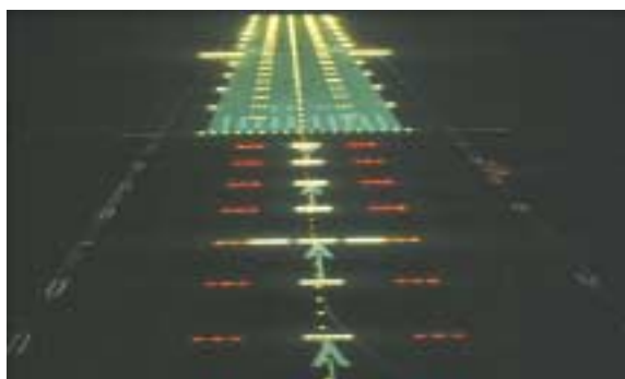
Balisage lumineux d'approche de précision
