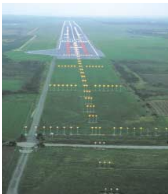
Aéroport de Brest - Guipavas. Ligne d'approche de catégorie III
