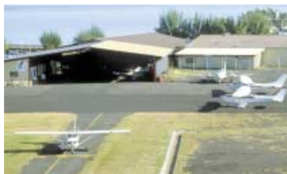
Aéroport de Tahiti - Faaa. Marques de point d'arrêt
