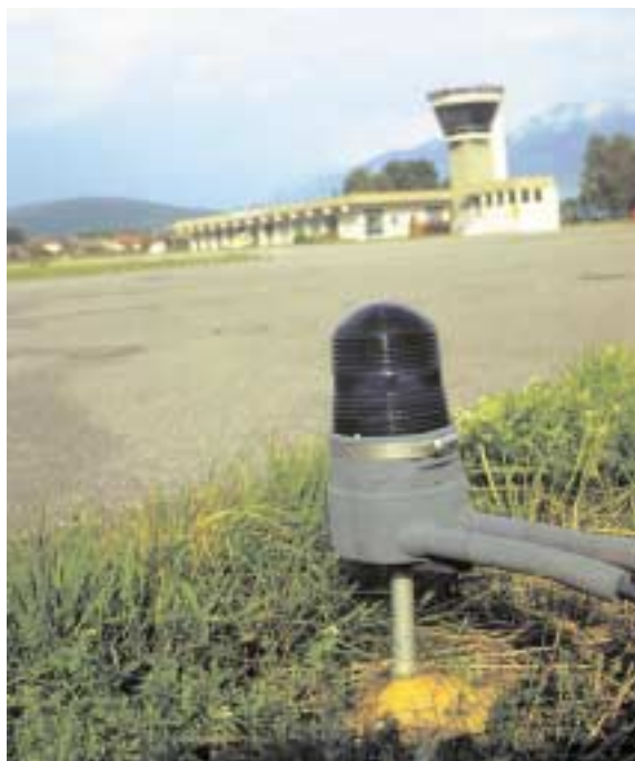
Aéroport d'Annecy - Meythet. Balise lumineuse de voie de relation
