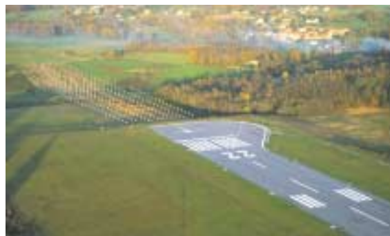
Aéroport de Limoges - Bellegarde. Plan de sol artificiel installé au seuil 22
