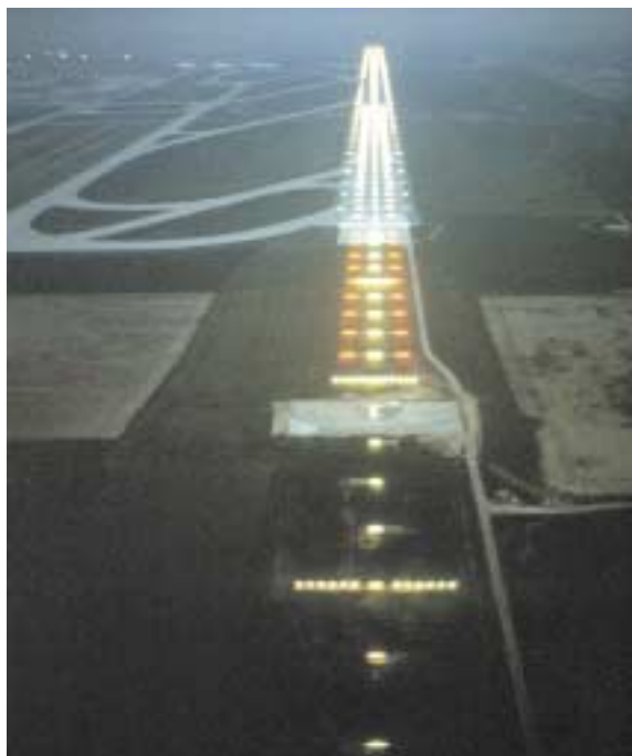
Aéroport de Paris-CDG. Ligne d'approche et balisage lumineux
